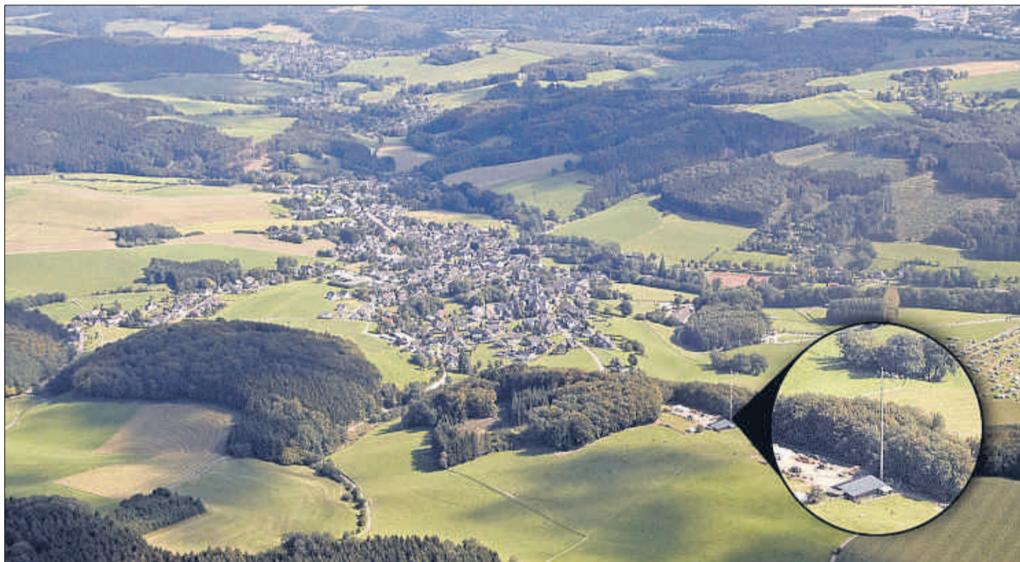
Das Luftbild zeigt das Siedlungsgebiet, das schon ab kommender Woche LTE-Abdeckung erhält. Vom Mast in Schlüsselberg aus - hier in der Lupe vergrößert - senden zwei LTE-Funkzellen über Kapellensüng, Hartegasse bis nach Brochhagen am Bildrand oben links. 873 Anschlüsse liegen in diesem Gebiet, 851 davon werden LTE buchen können. Durch Wald und Täler können Funkschatten entstehen. (Foto: hil/Grafik: blz)
