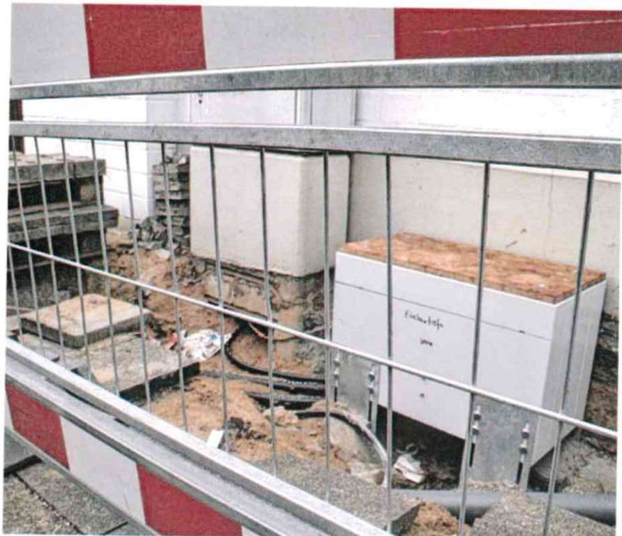
In Merken haben die Arbeiten bereits begonnen: Für das Glasfaserkabel ist ein zweiter Verteilerkasten notwendig. Fotos: Burkhard Giesen
