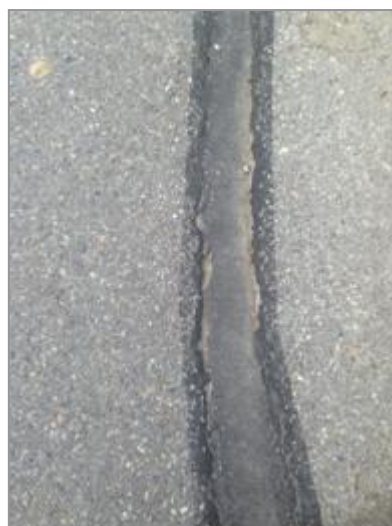
Abb. 3: Microtrenchingstrecke in Süddeutschland nach zwei Wintern
